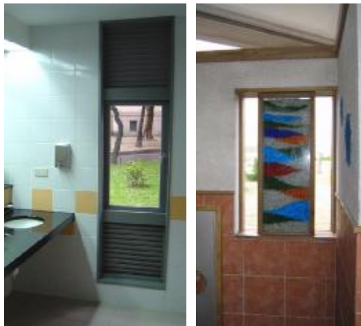
圖 1-77 百葉窗及洞窗於公廁中之使用設置
